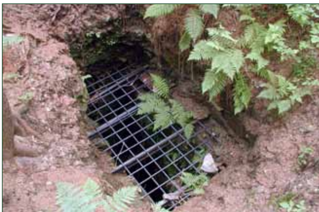
1. Šachta Kohlreuter | Schacht Kohlreuter | Kohlreuter Shaft
