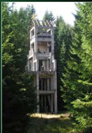
6. Přebuz: Hlavní jáma | Der Hauptschacht | Main Shaft
